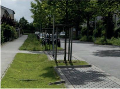
In diesem Zusammenhang wäre ggf. die Ausbildung von Retentionsmulden insbesondere entlang der Kaiserslauterner Straße vorstellbar. Dadurch könnte eine Entlastung der bei Starkregen überlasteten Kanalisation in diesem Bereich erzielt und zusätzlich durch eine attraktive Bepflanzung ein Beitrag zur Aufwertung des Stadtbildes erreicht werden.
