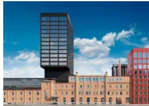
Hochhaus im Transformations- und Gewerbegebiet
