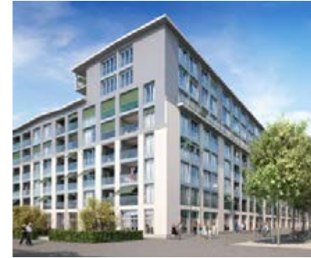
Hochpunkt im Wohnquartier
