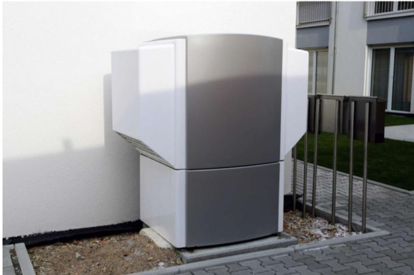
Abb. 2.3: Schallgedämmte Wärmepumpe<sup>6</sup>
