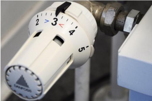
Das Thermostat vergleicht die gemessene Raumlufttemperatur mit dem Sollwert (der eingestellte Wert). Im Inneren sitzt ein Temperaturfühler, welcher das Ventil je nach gewählter Raumtemperatur öffnet und schließt. Jede Zahl entspricht einer bestimmten Temperatur.
