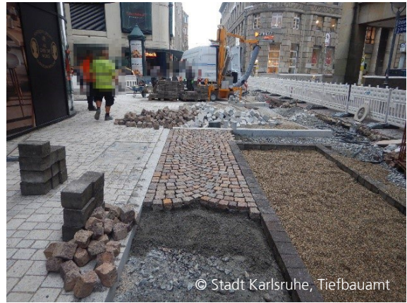
Abbildung 5: Verlegevarianten in den Kreuzungsbereichen
