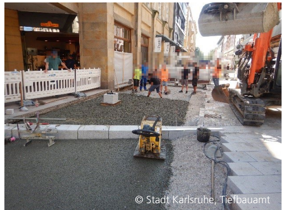
Abbildung 7: Herstellung der Dränbetontragschicht
