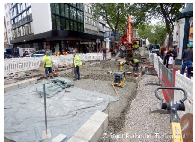
Abbildung 6: Herstellung der Dränbetontragschicht
