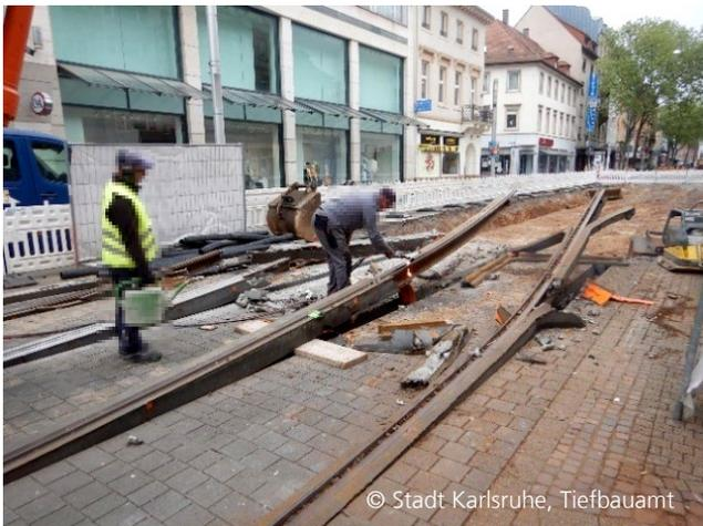
Abbildung 3: Ausbau der Schienen
