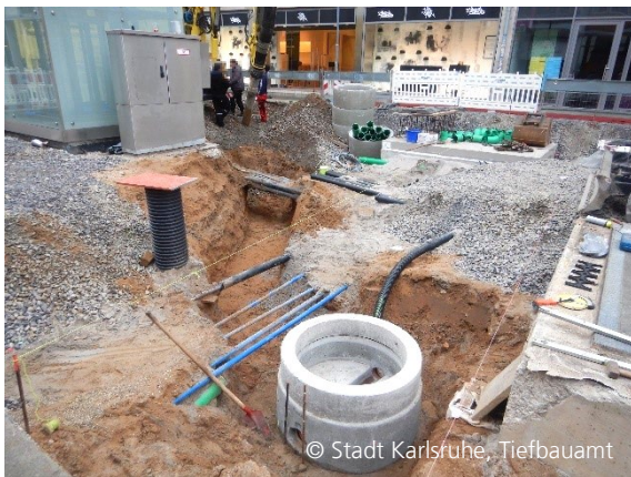
Abbildung 8: Leitungsbauarbeiten für Strom, Straßenbeleuchtung und Veranstaltungsinfrastruktur
