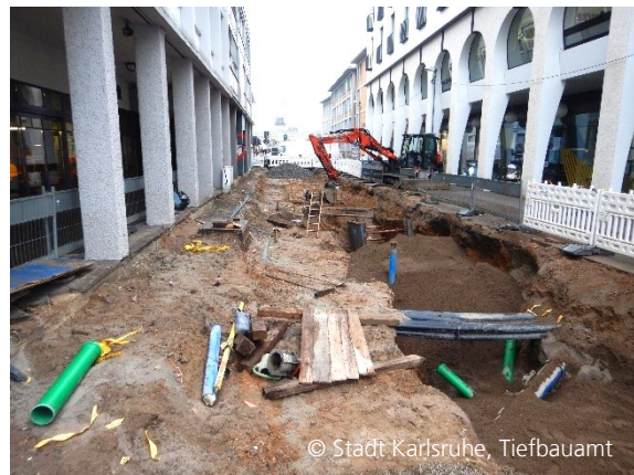
Abbildung 9: Karl-Friedrichstraße - Leitungsbauarbeiten für Brunnen, Bewässerungstechnik, Strom, Straßenbeleuchtung und Veranstaltungsinfrastruktur
