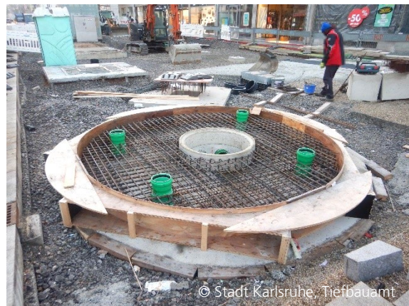
Abbildung 7: Fundamentierung und Entwässerung Lammbrunnen
