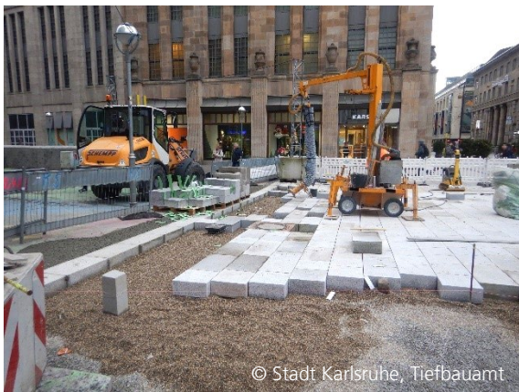
Abbildung 6: Verlegung Natursteinpflaster Kreuzung Lammstraße / Kaiserstraße
