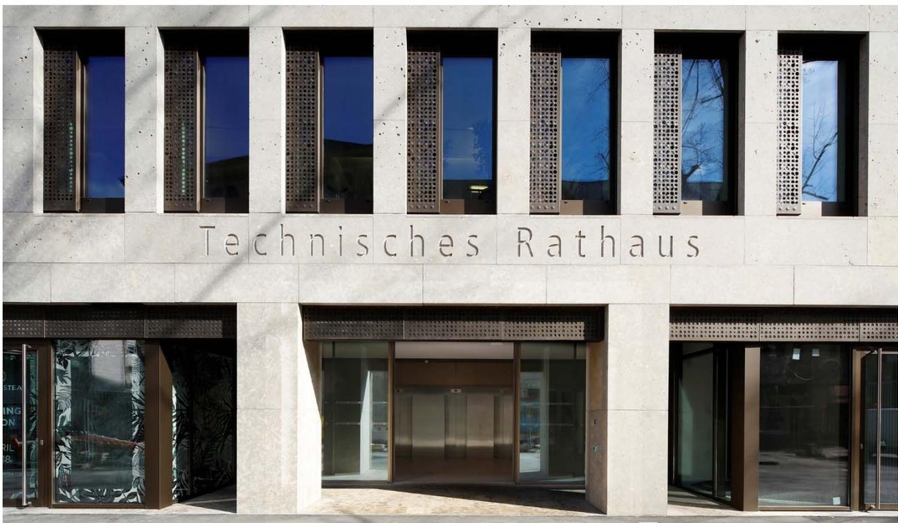
Abbildung 8: Lüftungsklappen am Technischen Rathaus Karlsruhe zur Unterstützung der Nachtauskühlung.
