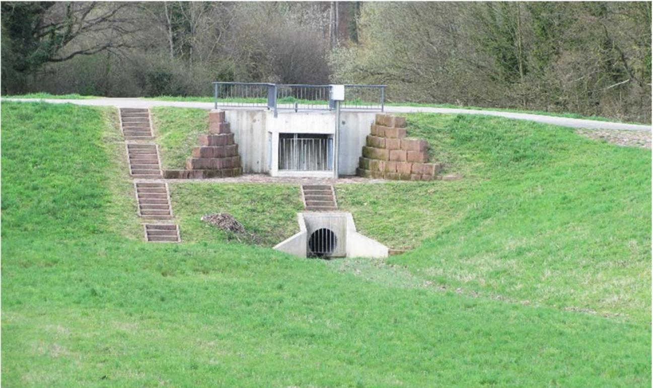
**Abbildung 79: Technischer Hochwasserschutz: Hochwasserrückhaltebecken „Am Rittnert“.**
