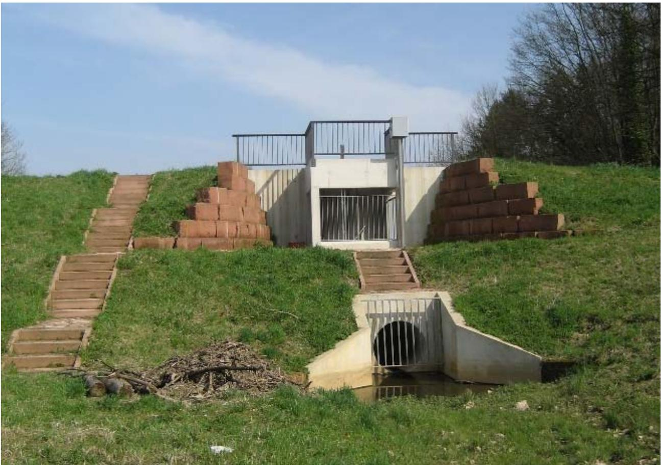
Abbildung 91: Blick auf die Doppelsteueranlage des Hochwasserrückhaltebeckens Rittnert. Foto: Stadt Karlsruhe, Tiefbauamt.
