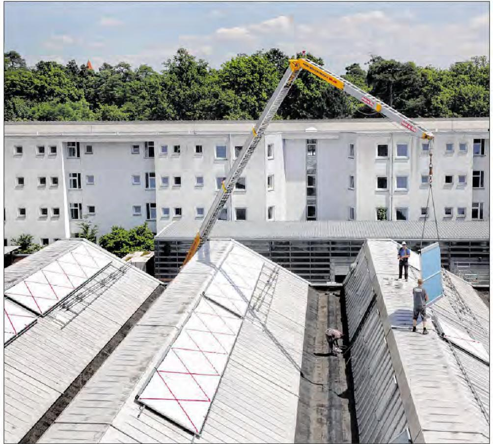
AUF DEM DACH des Laborgebäudes der Hochschule Karlsruhe – Technik und Wirtschaft wurden gestern die Solarkollektoren für ein Projekt zur solarthermischen Dampf- und Kaltwassererzeugung angebracht. Foto: jodo
