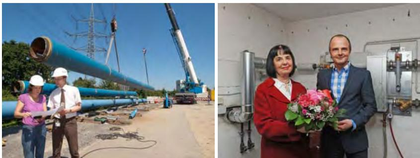
Links: Dritte Hauptleitung - Verlegung der Fernwärmerohre beim Lutherisch Wädele in Grünwinkel
