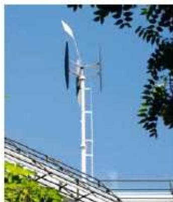
Windgeschwindigkeit ab 1,2 Metern pro Sekunde an und haben nur geringe Laufgeräusche. Die zweite Kleinwindanlage produziert auf dem Dach des Heizkraftwerkes an der Honselstraße Ökostrom. Sie hat doppelt so lange Rotorblätter und eine Leistung von zehn Kilowatt. Erwartet wird eine Produktion von zusammen etwa 13.000 Kilowattstunden Windstrom pro Jahr.
