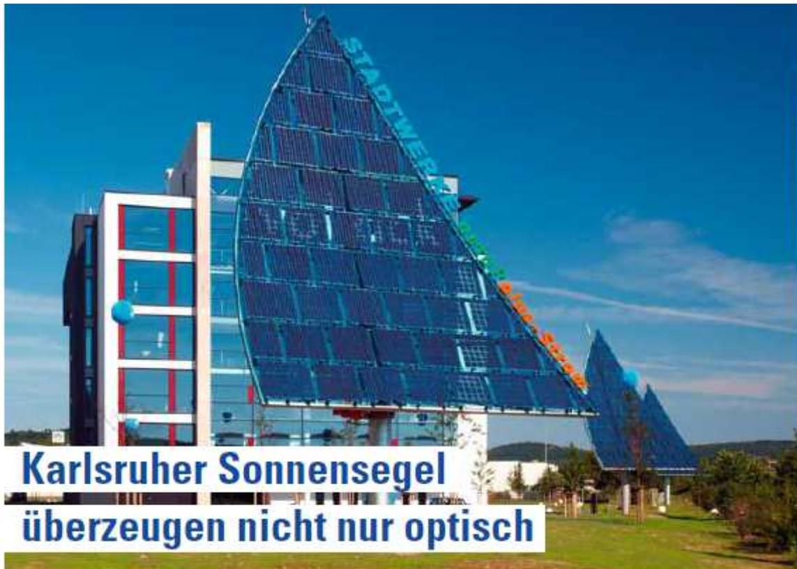
Im ersten Betriebsjahr haben die drei großen Solarsegel an der B 10 in Hagsfeld über 21.000 Kilowattstunden Strom produziert. Das sind 26 Prozent mehr als bei einer guten stationären Solaranlage.
