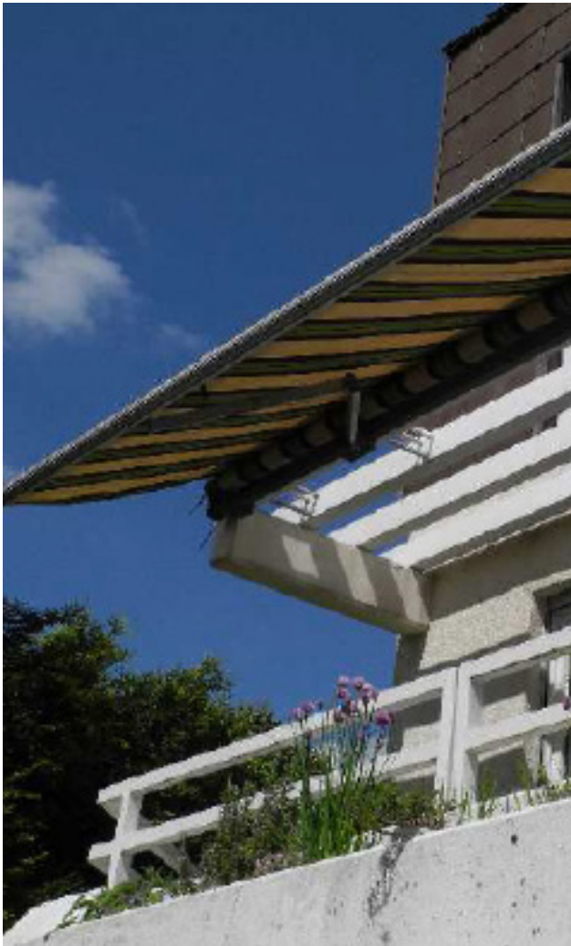
Abbildung 42: Verschattungselemente an Wohnhäusern in Karlsruhe
