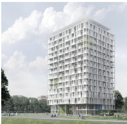
Abb. 58: Typenhochhaus Wohnungsbaugesellschaft HOWOGE Berlin
