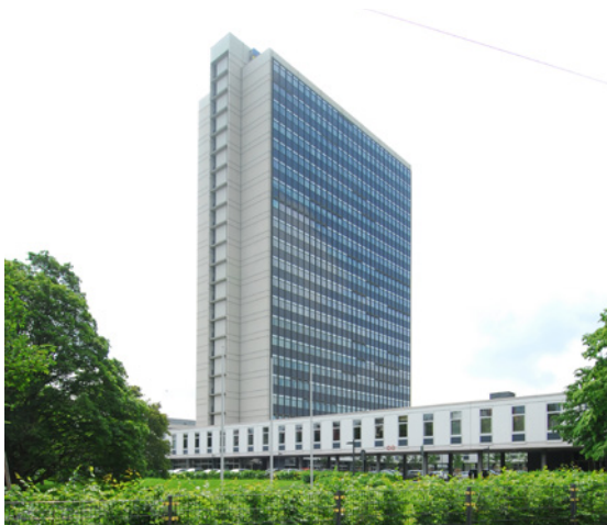
Abb. 64: Hochhaus der Deutschen Rentenversicherung als repräsentatives Gebäude
