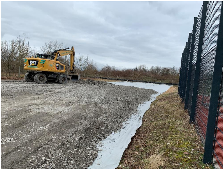
Abb. 1: Blick von der Südostecke auf die Bewegungsfläche; erkennbar ist das basale Geovlies, das mit Kalkschotter bedeckt wird.
