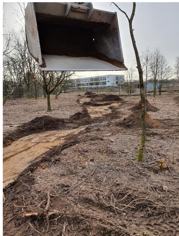
Abb. 4: Blick von Bereich 1 nach Südosten in Richtung des Bereiches 3; erkennbar ist der linienartige Verlauf der Bodenseparierung und der seitlich gelagerte Oberboden
