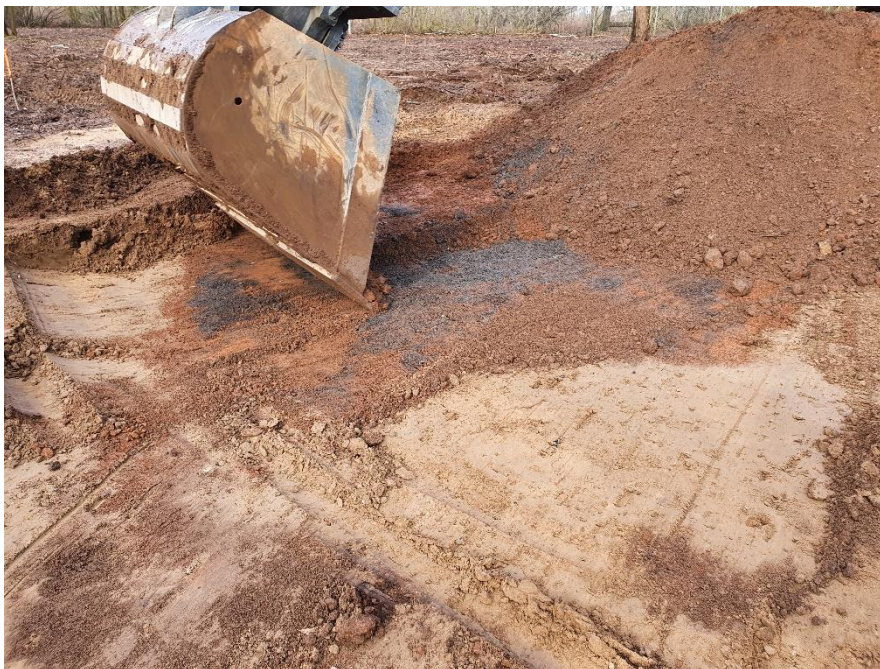
Abb. 2: Separierung der Schlackeschicht (dunkel) auf dem natürlichen Feinsand (hellgelb) im Bereich der Fläche 3
