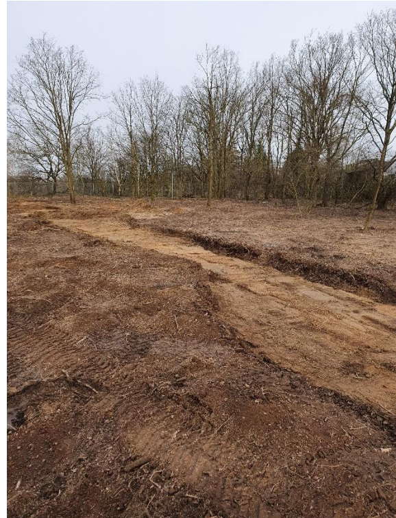
Abb. 5: Blick von Bereich 3 nach Nordwesten in Richtung des Bereiches 1
