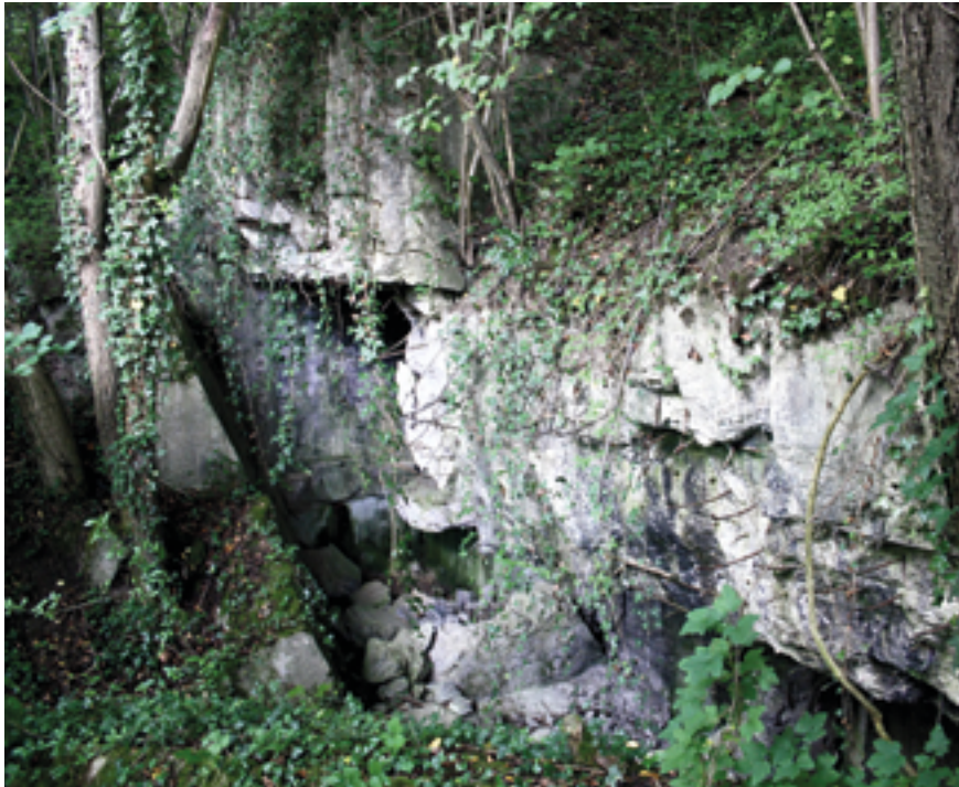
Reste der ehemaligen Flakstellung auf dem Grötzingener Knittelberg. Wasserbunker. Denkmalschutzobjekt. Foto: Creative-Commons-Lizenz | Beate Paland, 2010
