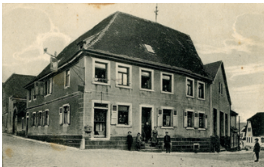
Aufnahme Gasthaus „Goldener Ochsen“ von 1915. Fachwerkgebäude mit Torbogen, Torbogen 1618. Fachwerkgebäude wohl von 1586 lt. Heimatbuch Mössinger. Vorher Standort des Gasthof „Roter Ochsen“. Erbaut vor 1532. Davor evtl. Weinschänke in Klosterbesitz (Keller erhalten). Wiederaufbau 1699 lt. Ochsen-Historie Huber. Heutiger Fassadenzustand Anfang 19. Jahrhundert, mehrfach überputzt. Im Inneren wohl älter (1586). Ältester Gasthof Grötzingens. Denkmal nach § 2 (Kulturdenkmal) Denkmalschutzgesetz. Foto: Pfinzgaumuseum UI 2379 (oben)
