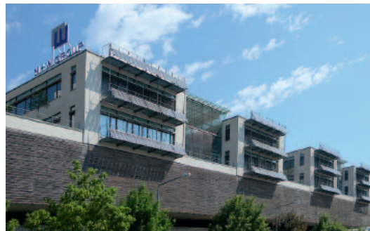
Nachhaltige Überbauung einer Fabrikationshalle
