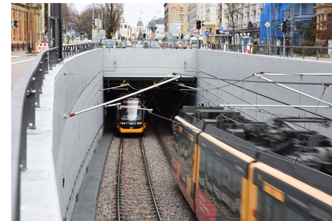
Unterirdischer Abschnitt der Straßen- und Stadtbahn
