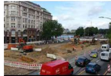
Baustellenkoordination / Örtliche Bauüberwachung
