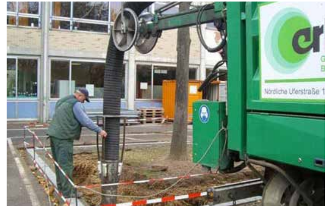
Baumsanierung: Hier wird das stark verdichtete Erdreich um die Wurzeln abgesaugt, um durch ein optimiertes Substrat (wie im unteren Bild) ersetzt zu werden.
