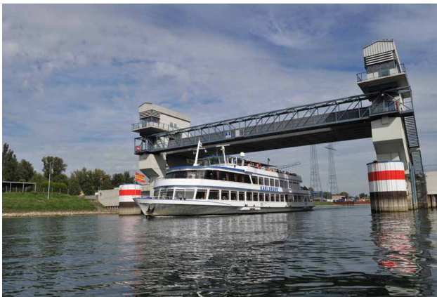
Hochwassersperrtor im Karlsruher Rheinhafen.
