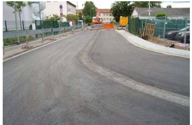
Einbau einer Mittelrinne in der Gablonzer Straße
