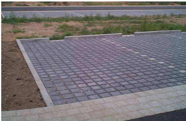
Entwässerung der Straßen und Parkplatzflächen im Baugebiet „Smiley“
