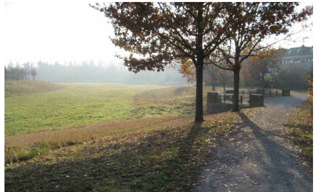
Regenwasserrückhaltebecken „Oberschmallen“ in Oberreut
