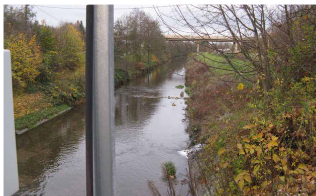
Hühnerlochwehr in Grötzingen: Am Überlaufwehr wird normalerweise das meiste Wasser in den Pfinzlauf geleitet. Bei Hochwasser läuft das Wasser in den Entlastungskanal (unteres Bild) über.
