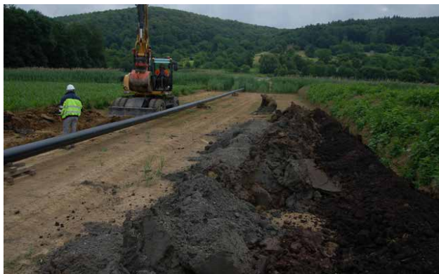
Bodenbeanspruchung durch Leitungsverlegung
